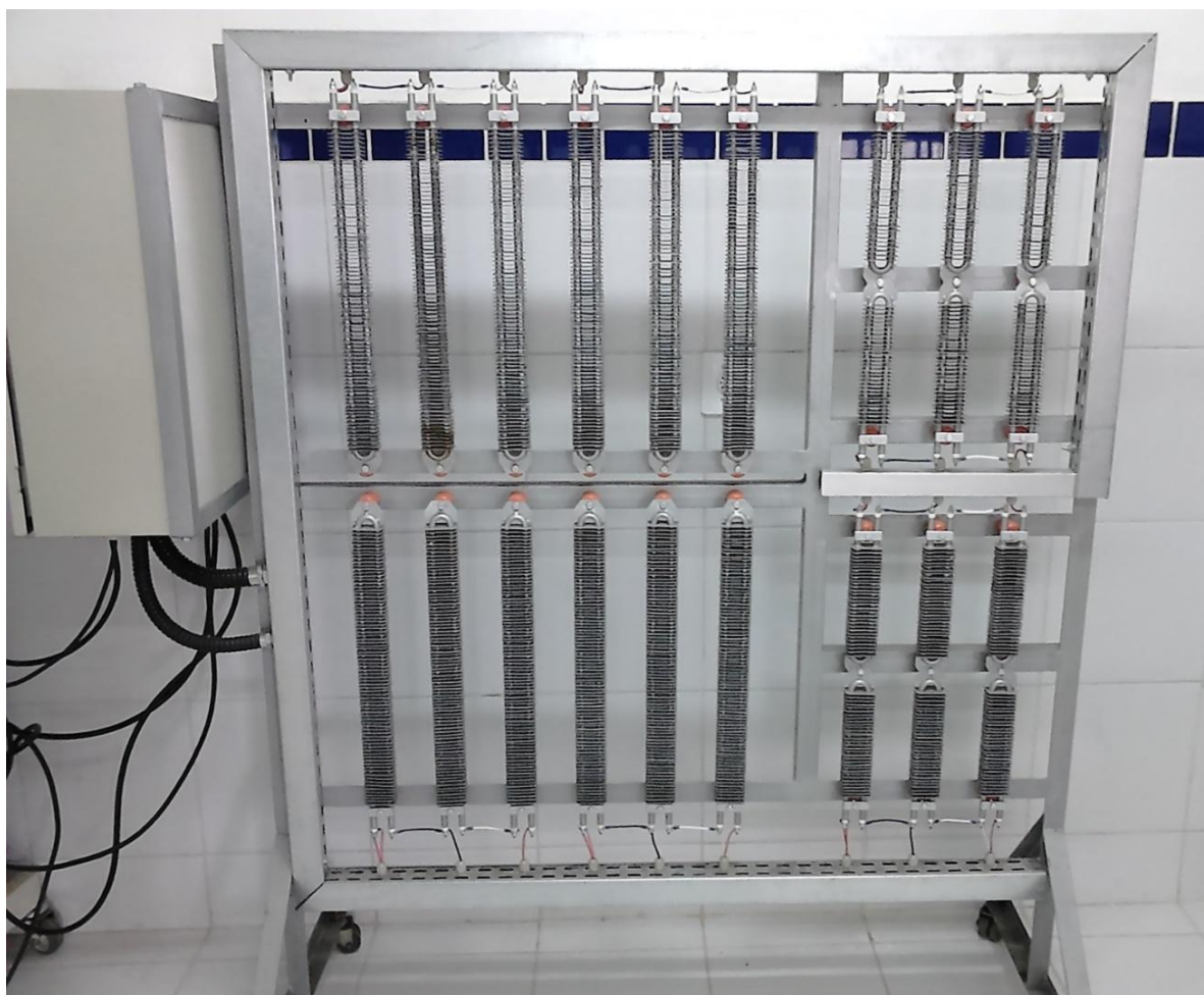
Figura 4: Sistema para aplicação de carga ao grupo gerador.
