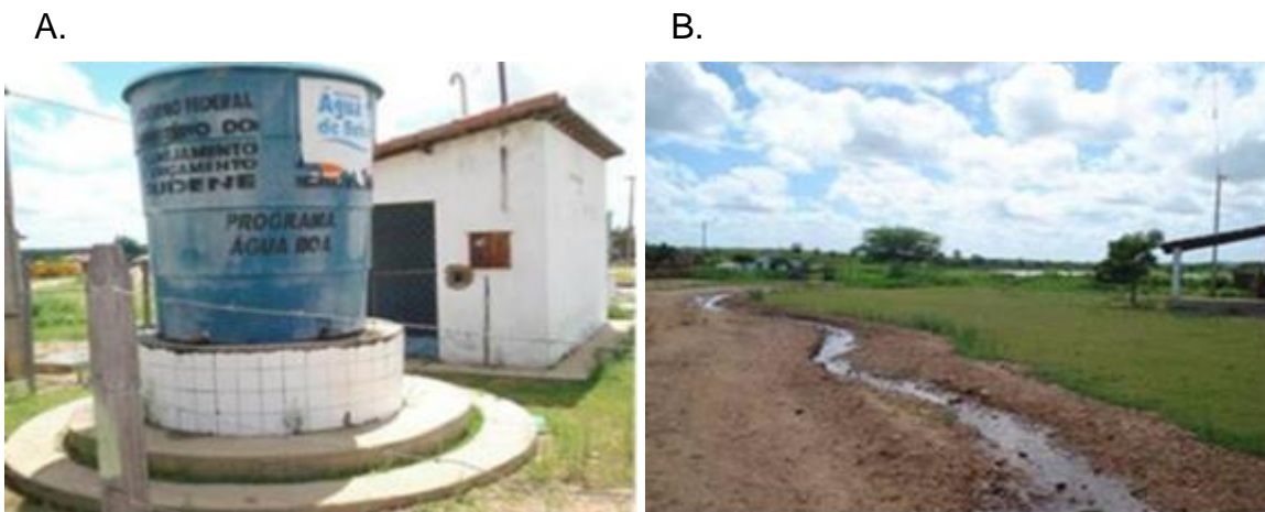
Figura 4. Localização da área de estudo na comunidade de Bom Jesus, Campo Grande, RN: Estação de tratamento da água salina (A) e rejeito salino lançado no solo seguindo o corpo hídrico (B).
