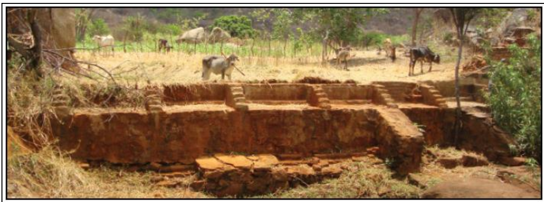
Figura 7 – Uma das quatro barragens de alvenaria de pedra e cal construídas no sítio Serra de São Miguel no início do século XX, e que, ao melhorar a disponibilidade de água, proporcionavam maior poder de suporte às populações humanas.
