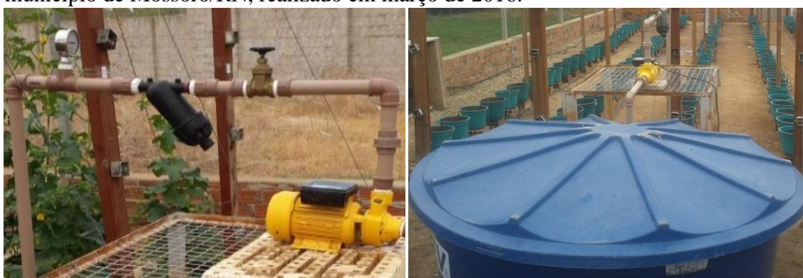
Figura 30 – Composição do sistema de bombeamento da irrigação utilizada no experimento em vasos, na casa de vegetação pertencente à UFERSA, localizada no município de Mossoró/RN, realizado em março de 2016.
