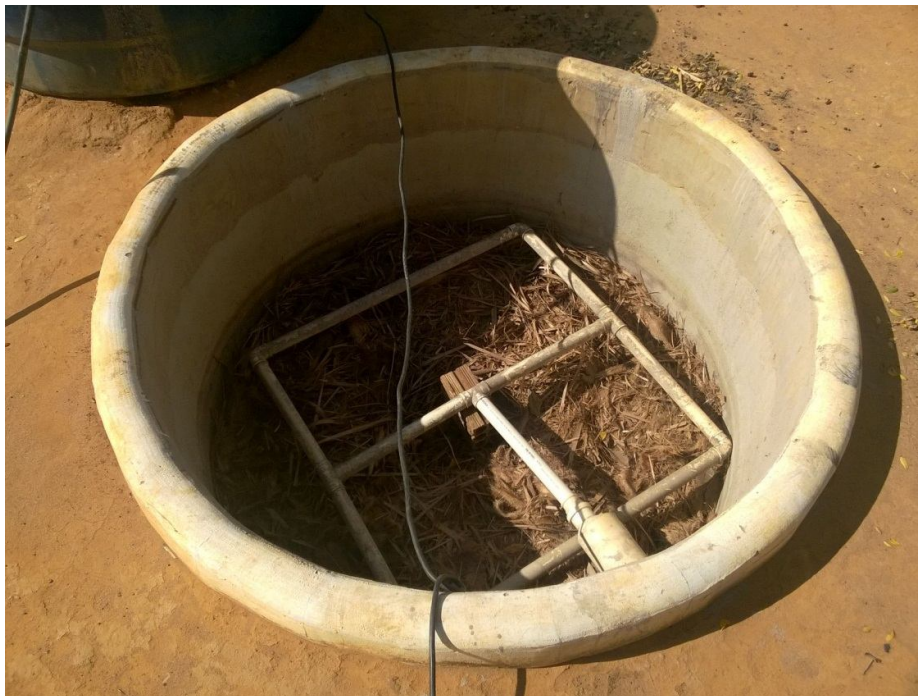
Figura 14. Vista superior do filtro orgânico de fluxo descendente. Fonte: Arquivo da pesquisadora (2017).
