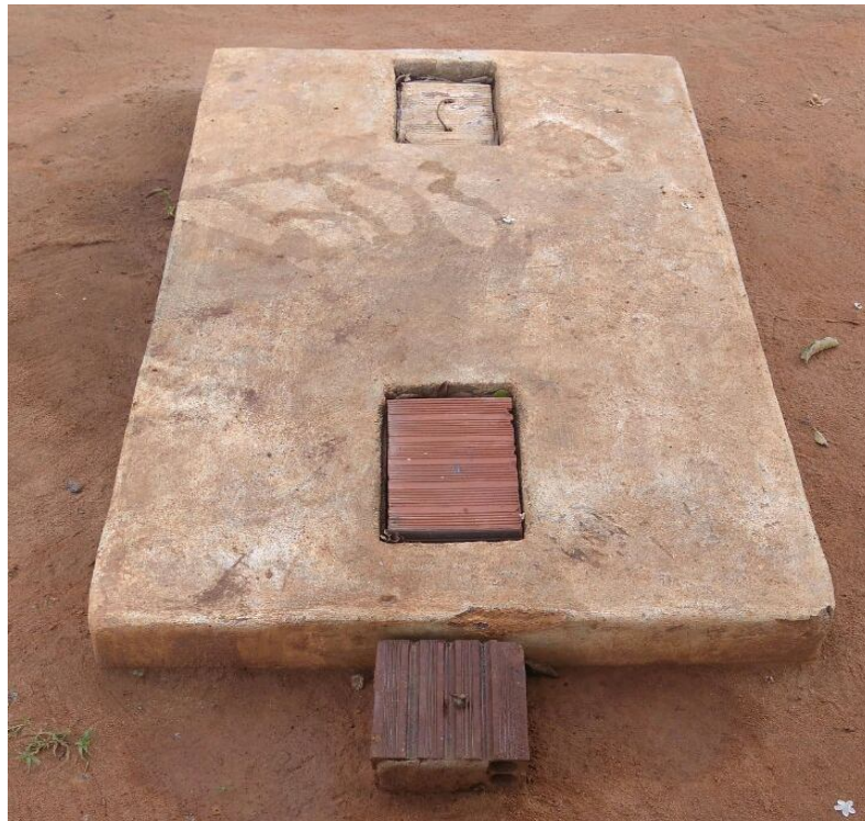
Figura 13. Vista superior do tanque séptico
