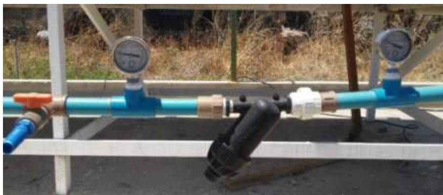
Figura 8. Manômetros instalados a montante e a jusante do sistema de filtração.
