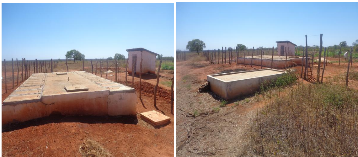
Figura 1 - Estação de tratamento de esgoto do assentamento Milagre, Apodi/RN.
