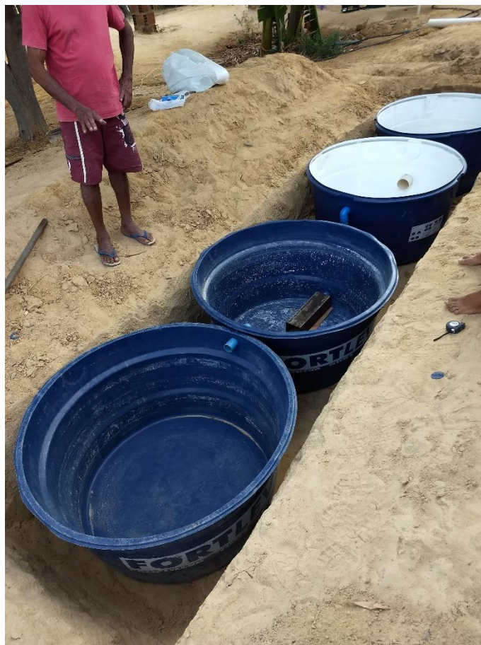
Figura 2. Construção do sistema de tratamento
