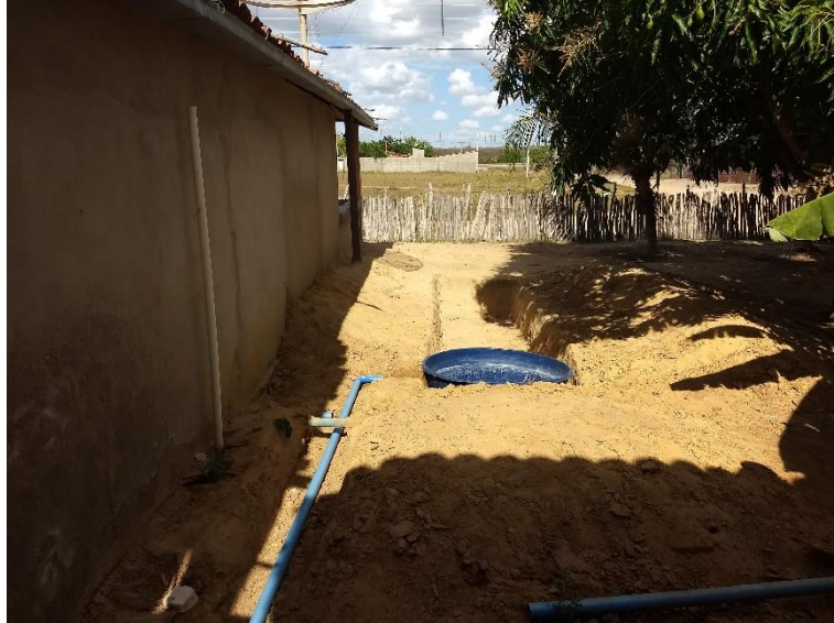
Figura 1. Escavação para a implantação do sistema de tratamento
