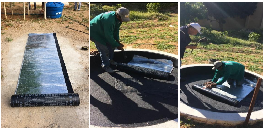
Figura 2. Aplicação da manta asfáltica com acabamento aluminizado no reator solar.
